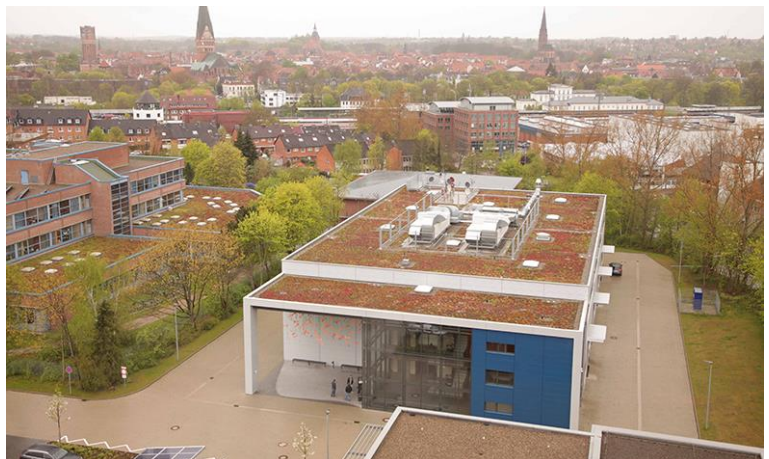
Das neue Werkstattzentrum in Lüneburg
